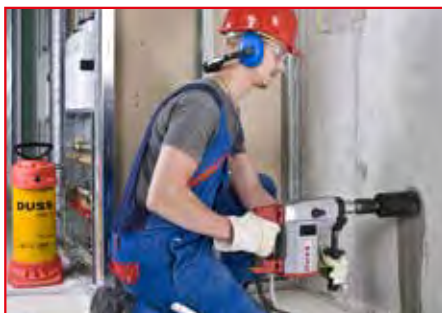
Dosensenken in Beton – nass, handgeführt
