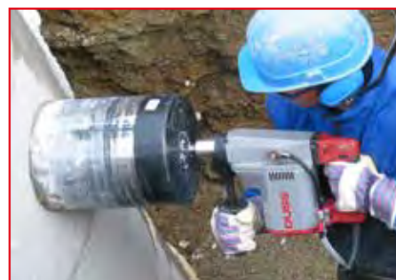
Anbohren von Betonschacht – nass, handgeführt
