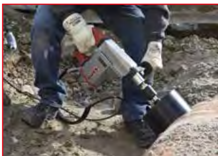
Anbohren von Kunststoffrohr – trocken, handgeführt
