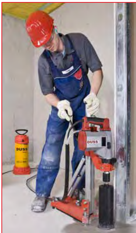
Nassbohren in Beton, ständergeführt
