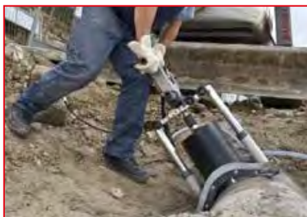
Anbohren von Betonrohr – nass, stativgeführt
