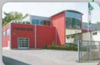
Hochregallager mit Verwaltung
