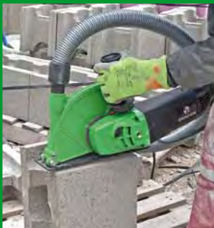
Bearbeiten von Schwerbetonsteinen
