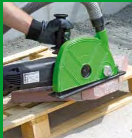
Trennen von Terrassenplatten
