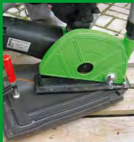
Trennen von Dachziegel
